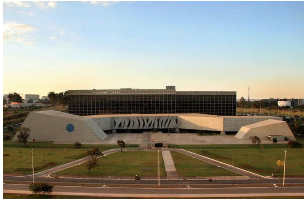
Figura 1 - Fachada frontal do complexo STJ
